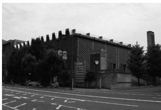
所在地：長野市字鶴賀緑町1647 開館：昭和36（1961）年 施設概要：大ホール（1828席）、集会室ほか ※2011年3月 閉館予定
