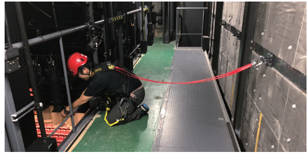
レストレインによる安全対策を行って作業をしている様子
