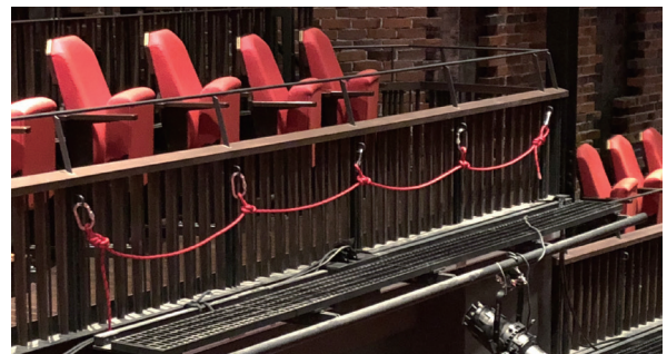
仮設水平ライフライン
